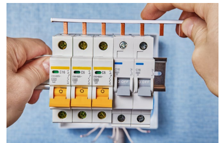
Abb. 22 Montage eines Schienenelements
